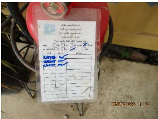
รูปที่ 32 ป้ายตรวจสอบสภาพพร้อมใช้งานถังดับเพลิง
