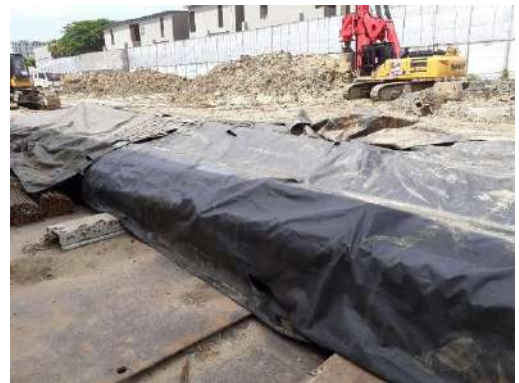
รูปที่ 64 ผ้าใบปิดคลุมวัสดุก่อสร้าง
