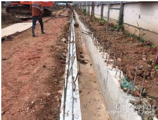
รูปที่ 62 รางระบายน้ำรอบพื้นที่โครงการ
