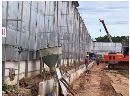
รูปที่ 62 รางระบายน้ำรอบพื้นที่โครงการ
