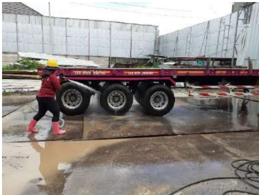
รูปที่ 9 พนักงานทำความสะอาดล้อรถบรรทุกก่อนออกจากโครงการ
